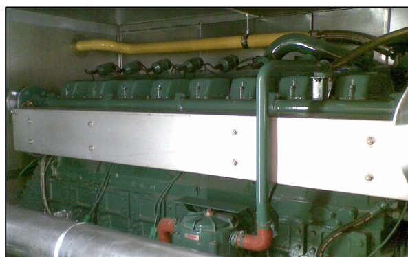
Warmtekrachtkoppeling in het Justitiepaleis van Brussel
